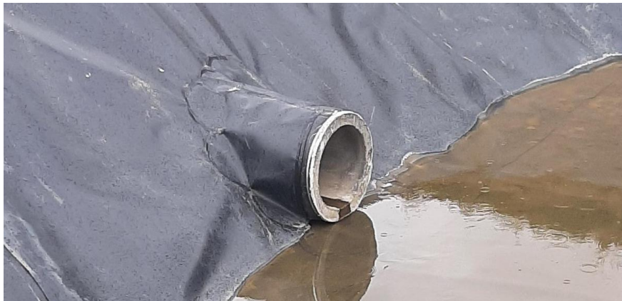
Foto 5 Hemelwater dat het bufferbekken binnenkomt
