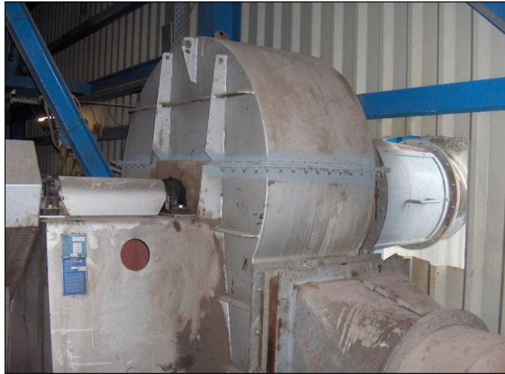
Foto 10 Afzuigventilator
