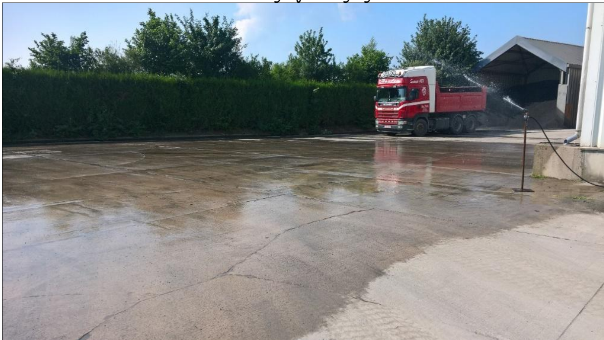
Foto 4 Betonverharding bij de uitgang van de laadzone
